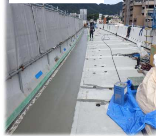
②-3床版コンクリート打設後
