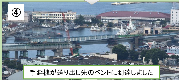
橋桁(水色)と手延機(緑色)を手前の橋桁上で組み立てます
