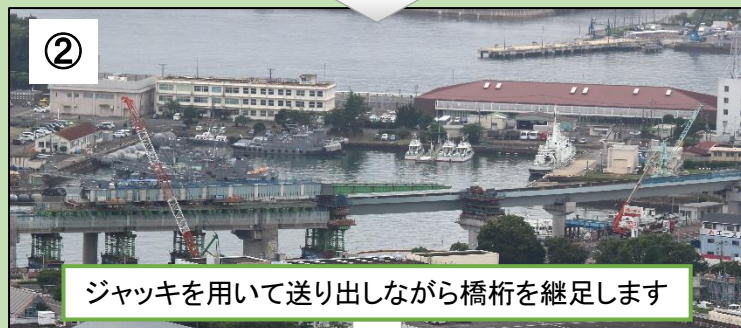
橋桁(水色)と手延機(緑色)を手前の橋桁上で組み立てます
