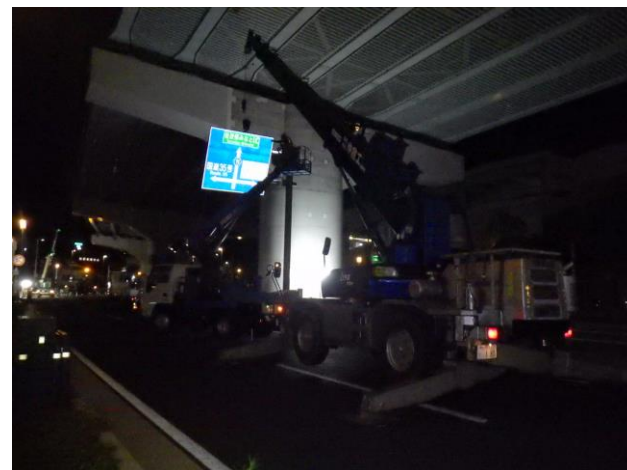
県道11号標識復旧状況
