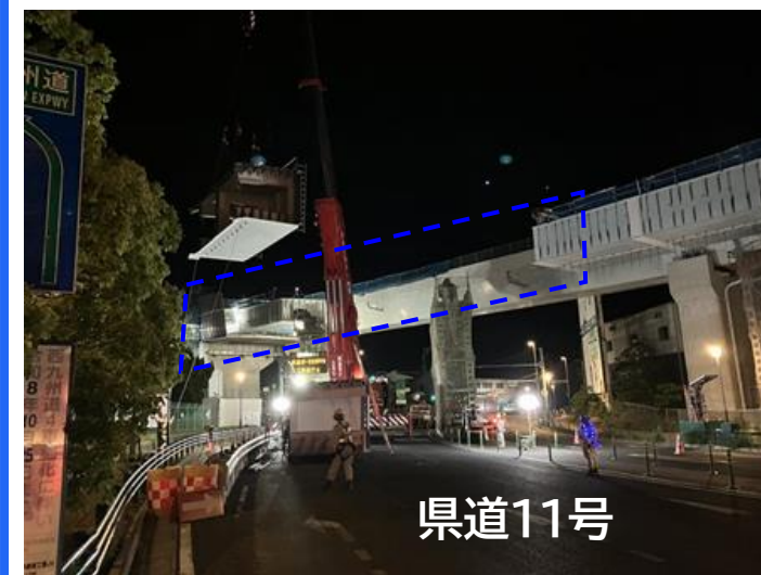
橋桁架設作業状況
