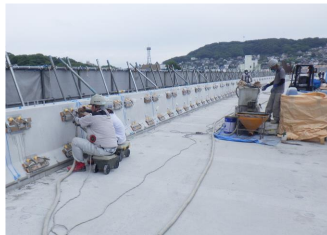
壁高欄施工状況
