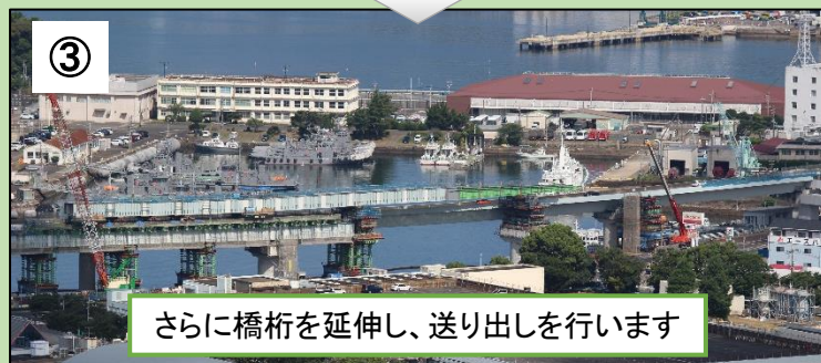
ジャッキを用いて送り出しながら橋桁を継ぎ足します
