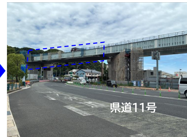
橋桁架設完了
