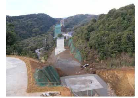
③ 田久保川橋(下部工)工事
