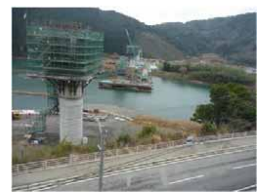
② 耳川橋(下部工)工事
