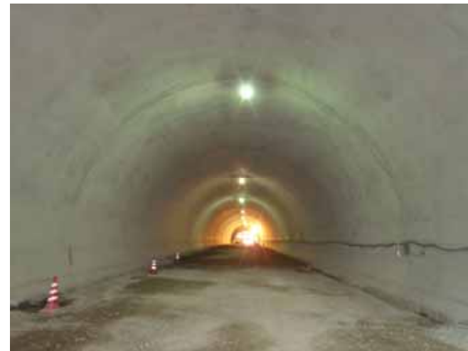
鹿場第二トンネル
