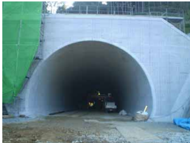
飯谷第一トンネル
