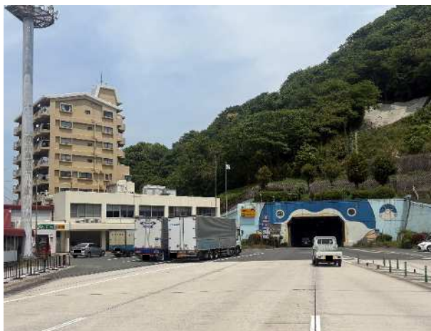
門司料金所（坑口側）
