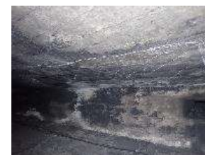
床版下面の鉄筋露出
