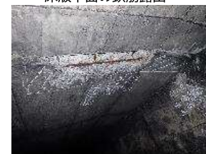
床版下面の鉄筋露出
