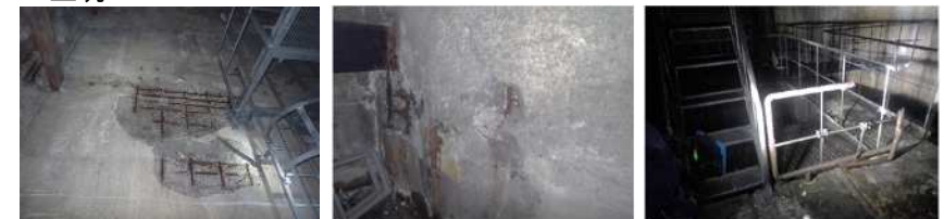
エレベーターシャフト 壁面の鉄筋露出
