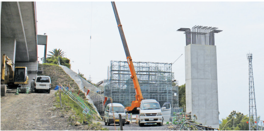
橋台工事の様子
