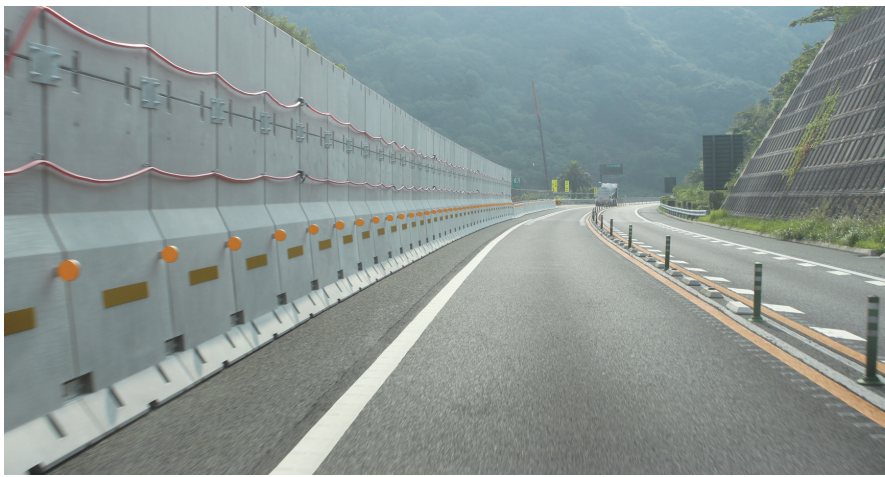
大坂トンネル付近 路肩防護柵
