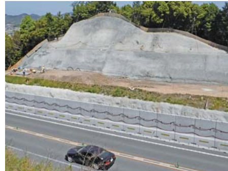
本線切土状況
