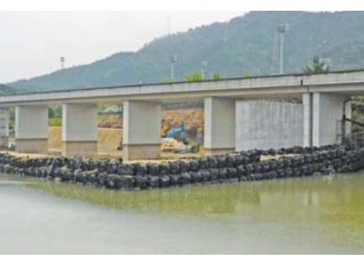
宮池橋(下部工)工事
