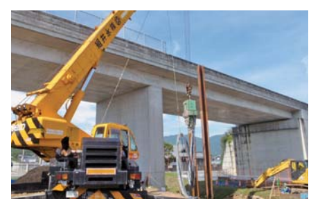
仮設橋施工状況
