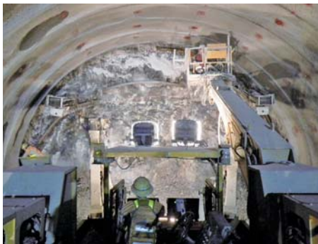
支保工建込状況
