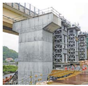
ベント組立状況
