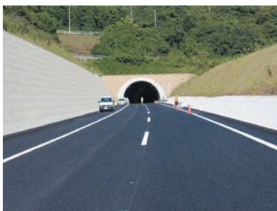
三木トンネル西坑口
