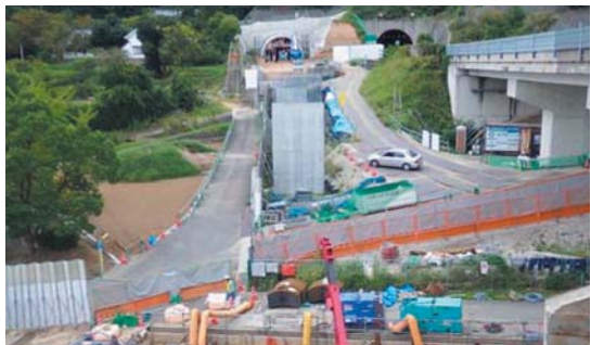
津田トンネル西坑口
