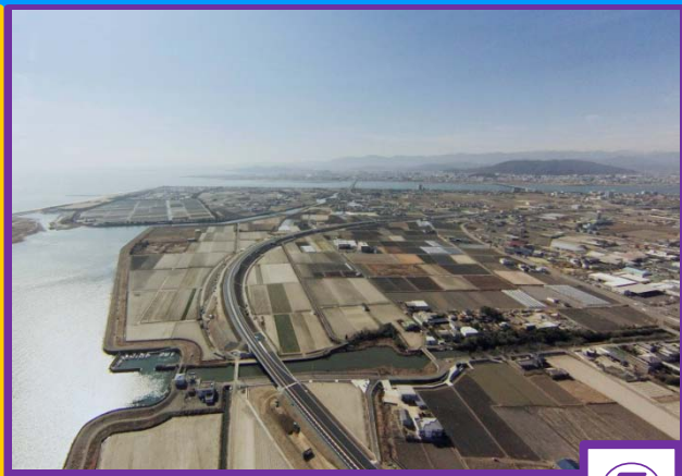
徳島JCT（仮称）予定地
