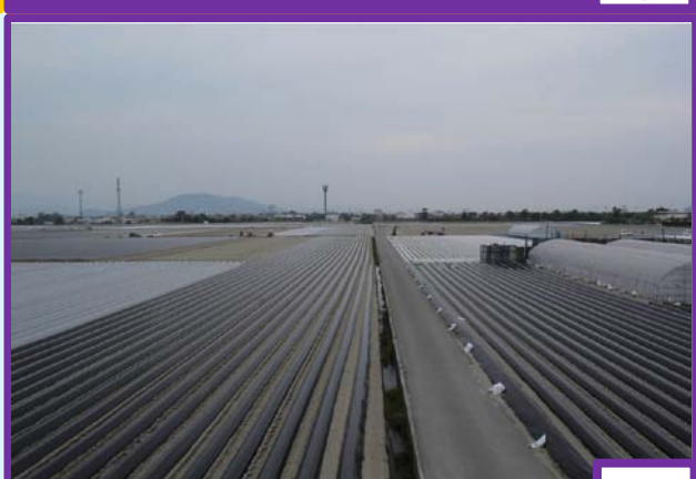
盛土施工予定地
