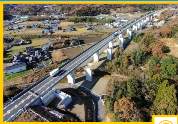
吹田高架橋 下部工
