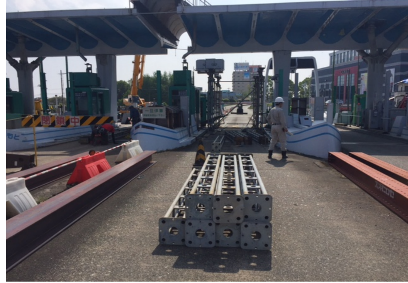
平成28年4月19日14時 撤去作業状況
