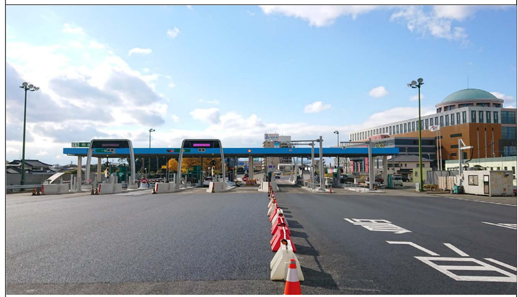
平成29年11月19日 鉄骨造トルゲート建て替え完了
