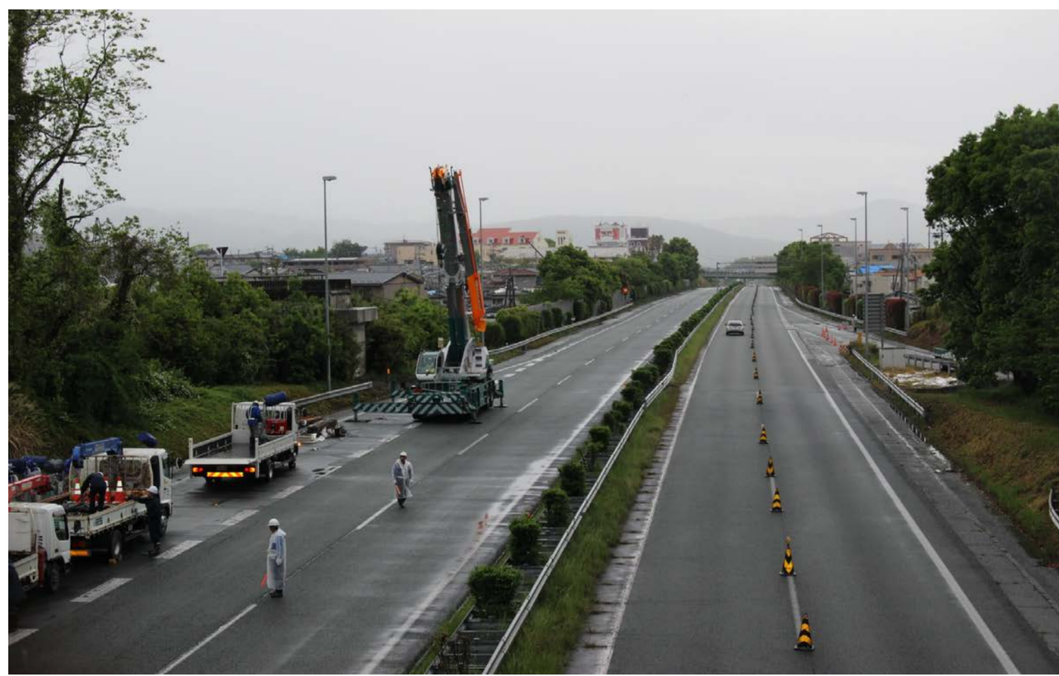
平成28年4月27日10時 撤去作業状況
