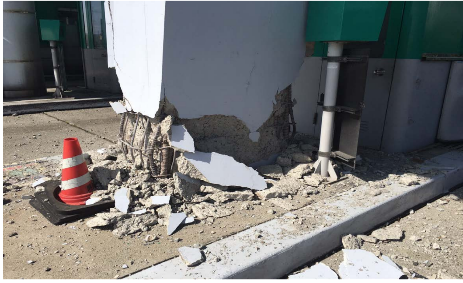
平成28年4月16日10時 被災後の状況
