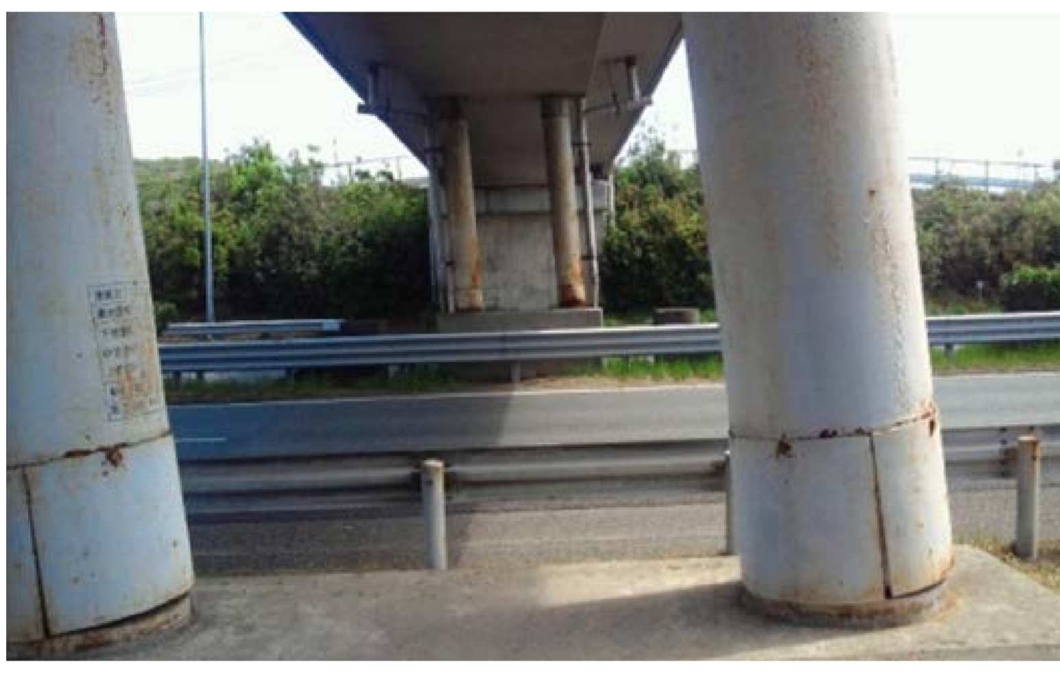
平成28年4月16日 13時 被災後の状況
