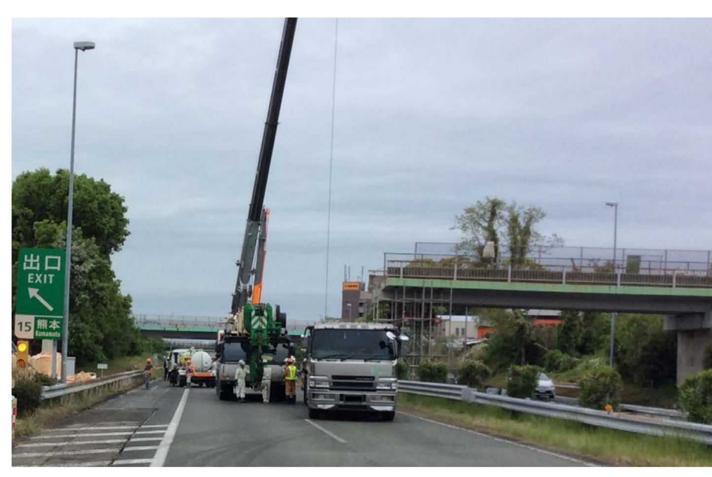
平成28年4月25日10時 撤去作業状況
