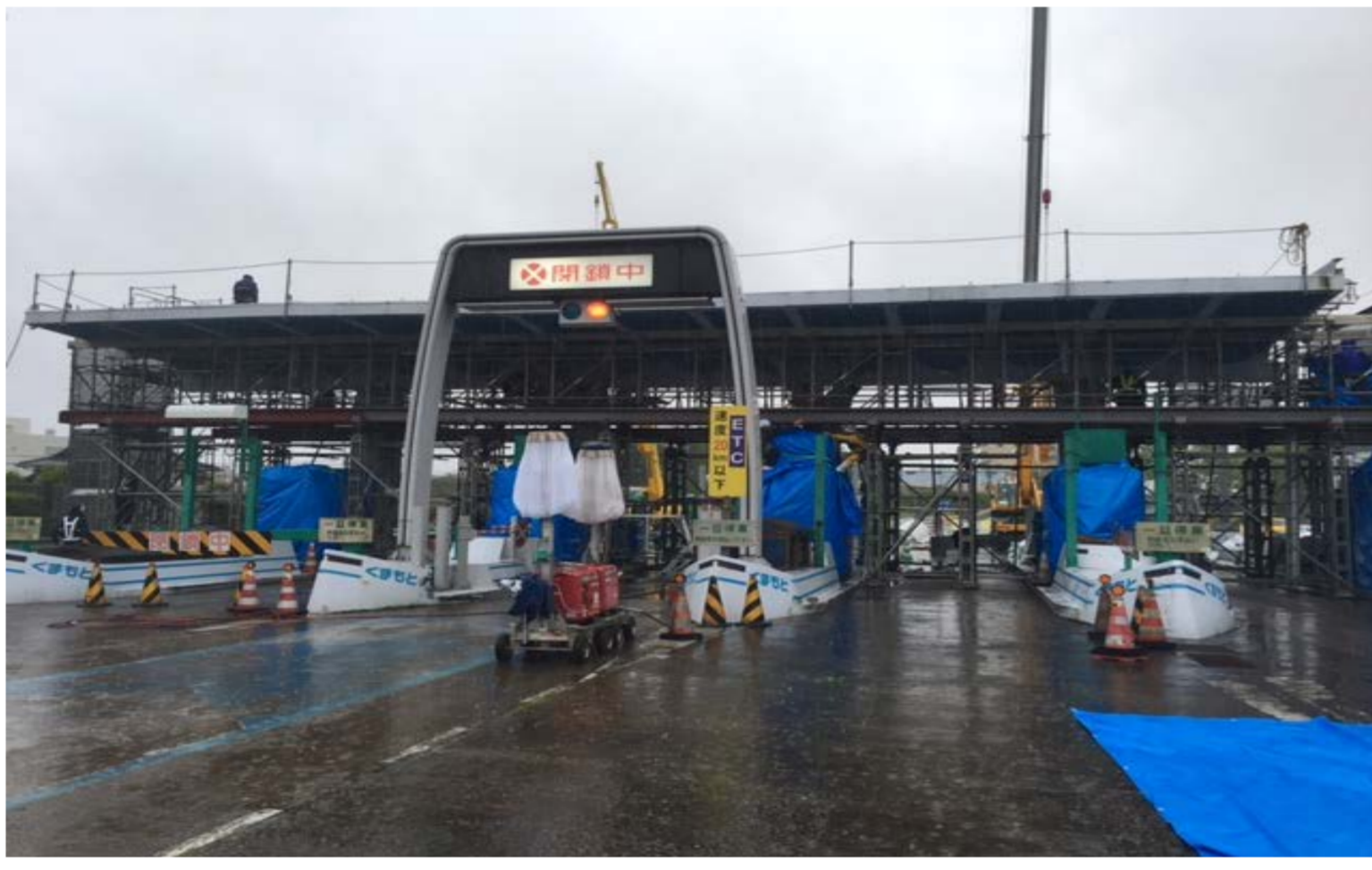
平成28年4月21日15時 撤去作業状況
