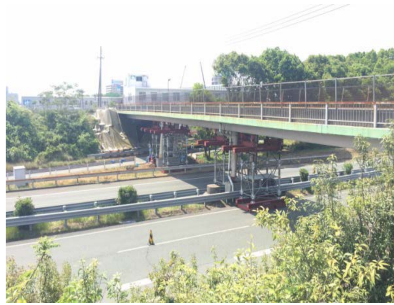
平成28年4月19日13時 応急復旧作業完了
