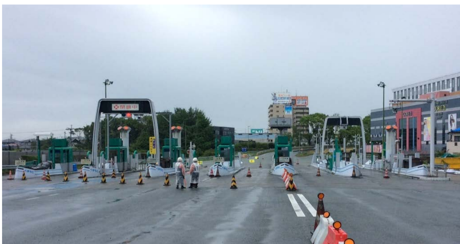
平成28年4月27日17時 撤去作業状況
