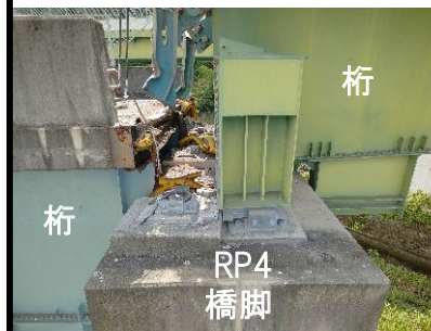
桁が脱落し、路面に大きな段差が生じている
