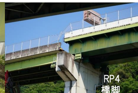
桁が脱落し、路面に大きな段差が生じている
