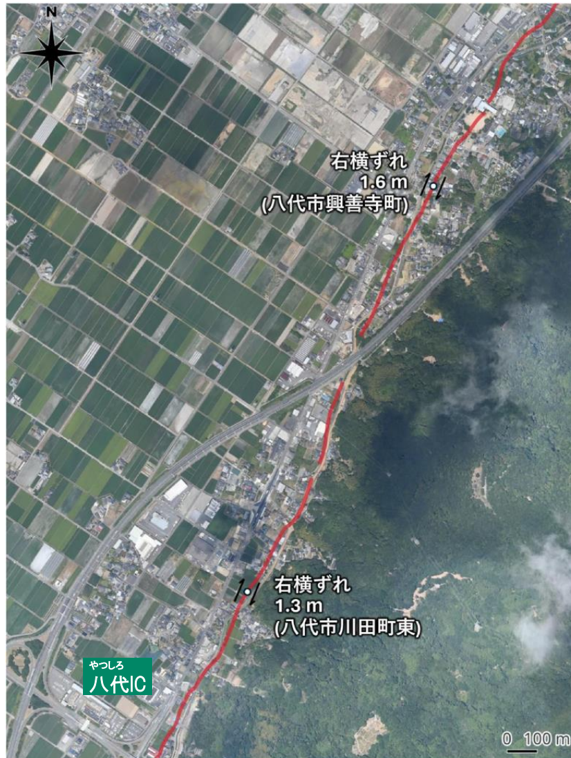
図 5 八代市興善寺町～川田町東付近の変位境界
