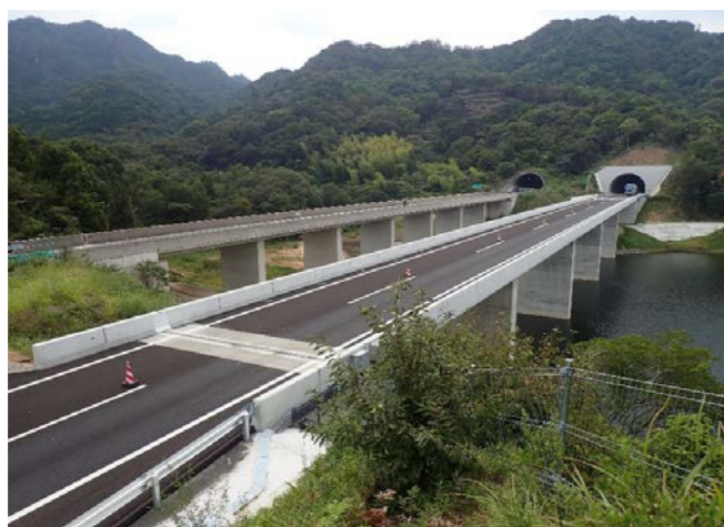
【白鳥トンネル東坑口付近】 写真1
