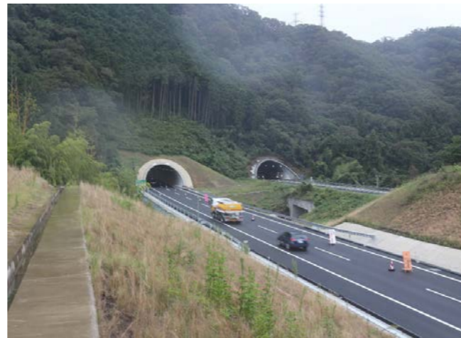
【南唱谷トンネル西坑口付近】 写真2
