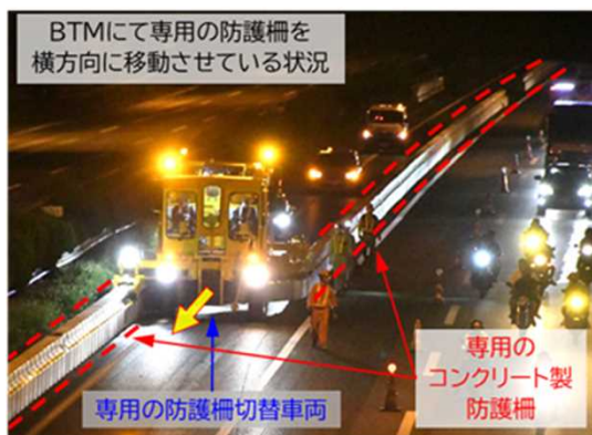
防護柵切替車両を用いた速やかな防護柵設置事例
