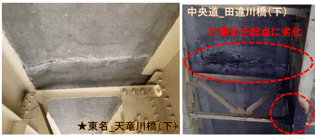
〈打継目の劣化進行の例〉
