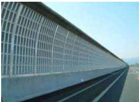
(遮音壁設置の実施例)
