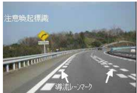
速度超過事故防止のため、速度抑制対策とし、
