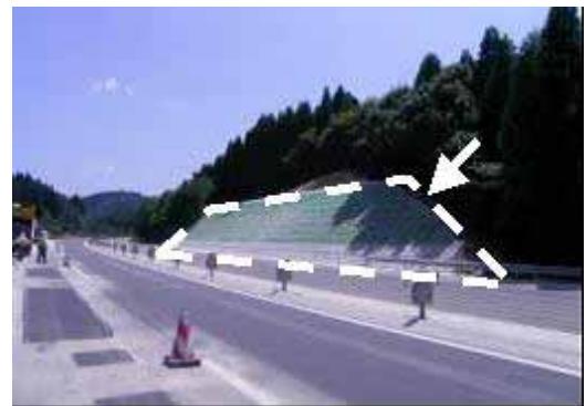
(のり面補強の実施例)
