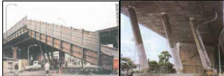
瓦木西高架橋
