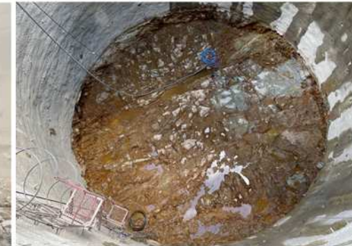
<P4橋脚基礎部の掘削完了状況>
