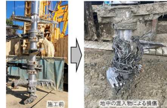
<地中の混入物による地盤改良機の損傷>
