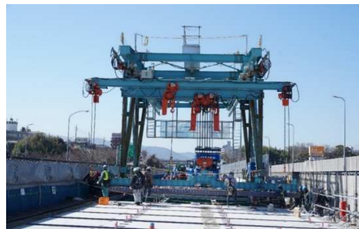
中国道における床版取替状況
