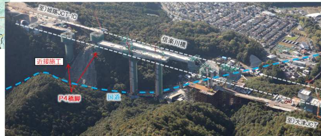
信楽川橋の状況(2024年11月撮影)
