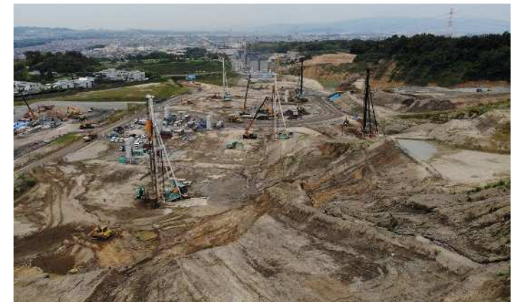
地盤改良施工状況
