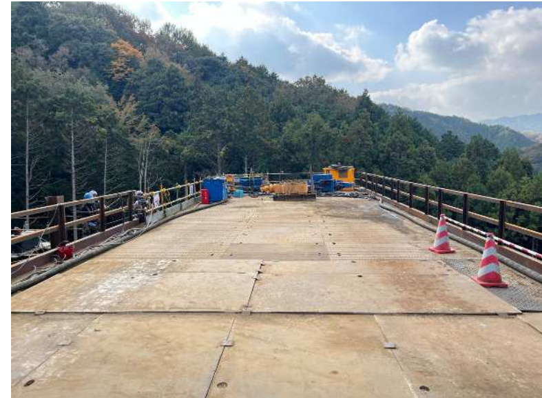
工事用道路仮栈橋の橋面に再利用
