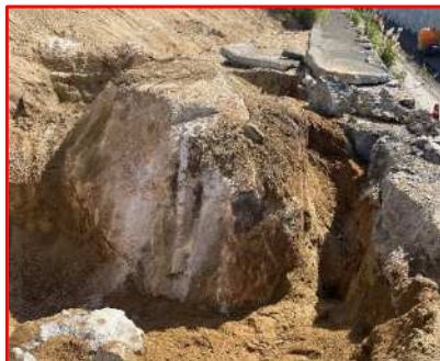
大型ブレイカーにて施工を試みたが、破碎できなかった
