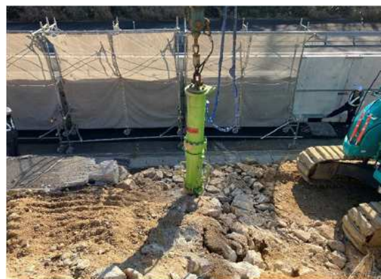
③油圧式破碎完了
