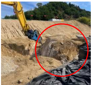
大型ブレイカーの施工状況
