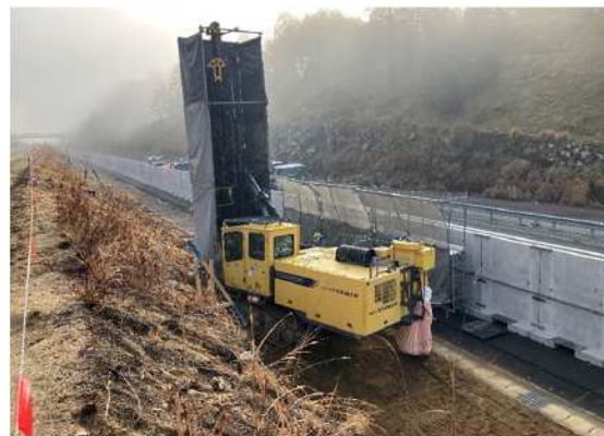
①クローラドリルによる削孔
