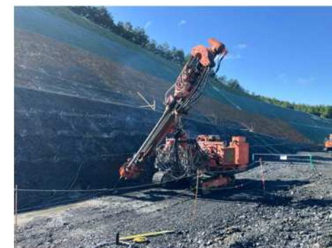
切土補強土工(他工事施工状況)
