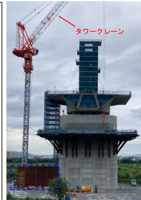
▲設置状況写真(タワークレーン)
