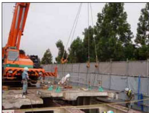
既設床版の撤去
