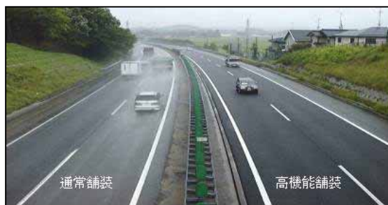
通常舗装と高機能舗装との比較例
