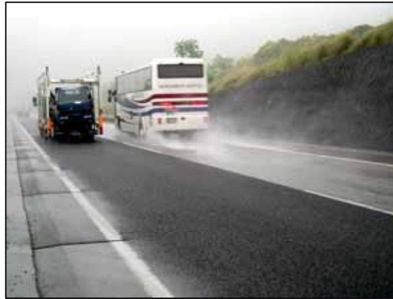
高機能舗装施工前後の状況 右車線が従来舗装、左車線が高機能舗装
