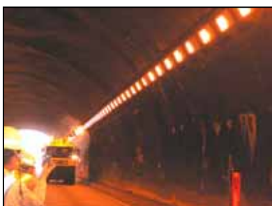
トンネル照明器具の清掃状況
