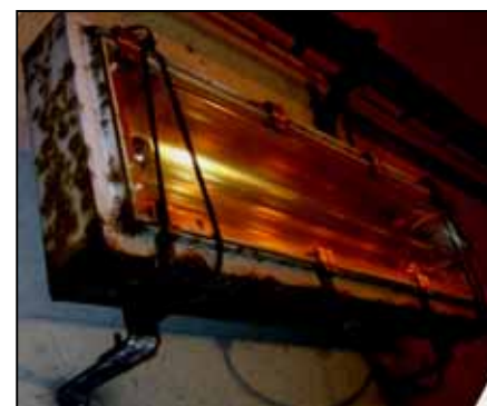
トンネル照明の劣化状況
