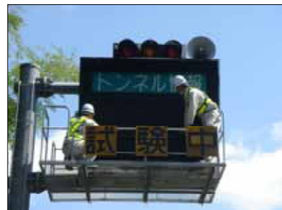
情報板の点検
