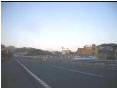
第二神明道路 和歌山5.5 付近 (整備前)
