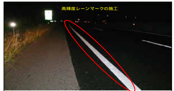
高輝度レーンマークの整備例
