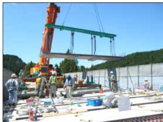
PC床版を用いた床版取替え
