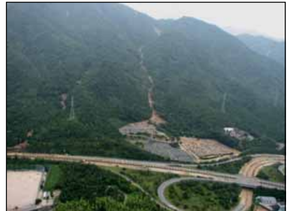
中国道 山口 IC 付近の災害状況
