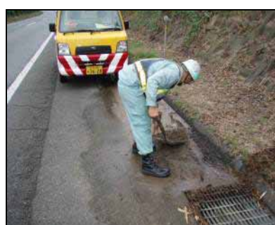
道路脇の排水ます清掃状況
