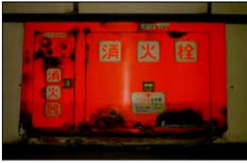
トンネル消火栓の劣化状況と取替事例
