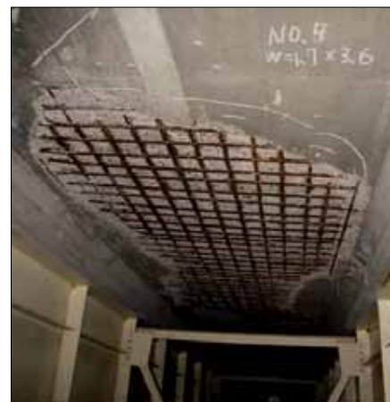
橋梁床版下面の剥離状態
