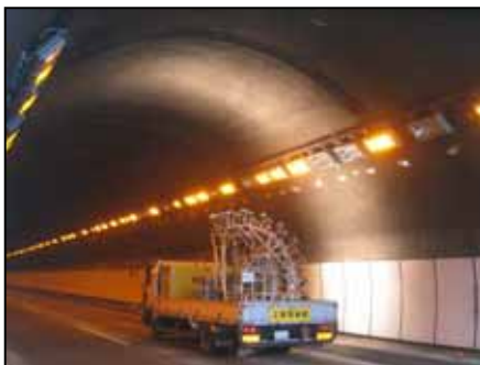
トンネル覆工撮影状況
