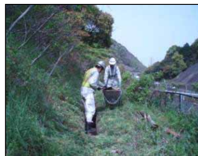
斜面における排水溝の清掃状況
