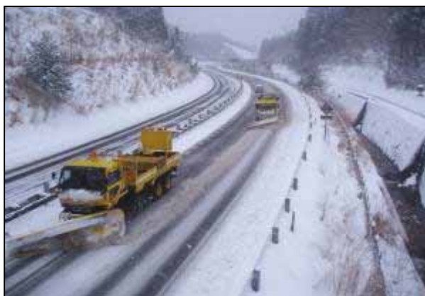
高速道路における除雪作業状況
