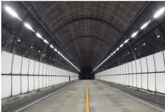
<トンネル照明のLED化>
