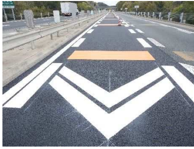
<舗装改良及び導流レーンマーク>
