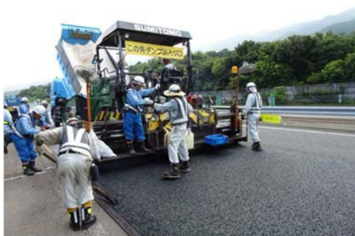
<終日車線規制等における舗装補修状況>
