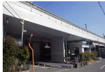
《橋梁上部工はく落対策(補修後)》
