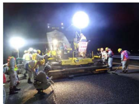
<終日車線規制等における舗装補修状況>
