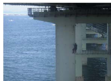
<橋梁の点検状況>
