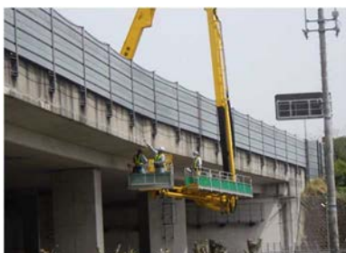
<橋梁の点検状況>
