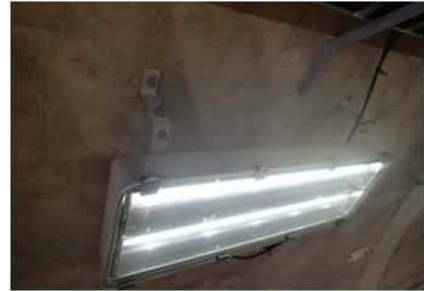
《トンネル照明の緊急補修(補修後)》
