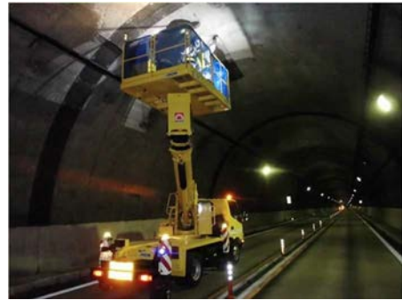
《トンネル覆工の点検状況》
