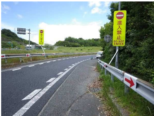
《一般道接続部の対策状況》
