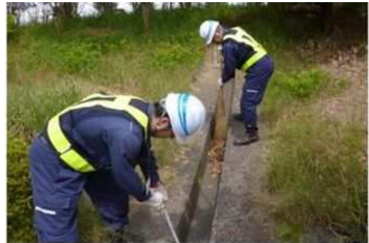
<不動産管理点検時の排水溝清掃>
