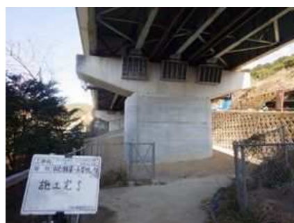
<補強後(コンクリート巻立て、支承補強)>
