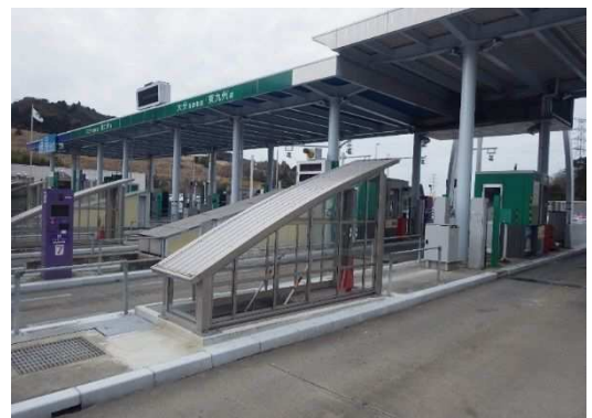
< 料金所地下通路 >
