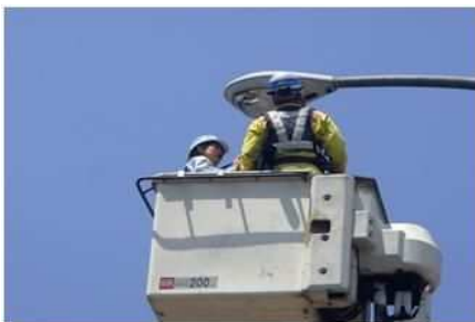
《道路照明の点検状況》
