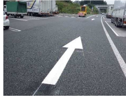
<休憩施設スルーレーンに矢印路面標示>
