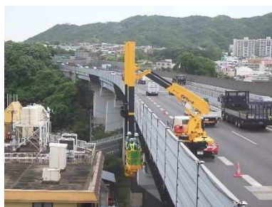
<遮音壁の点検状況>
