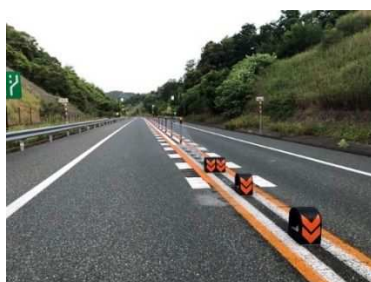
<ワイヤロープの設置(土工部)>
