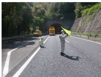
<路面の点検状況>
