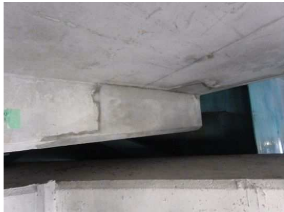
《橋梁桁端部補修(橋梁)》
