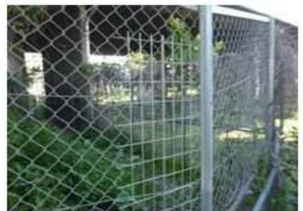
<立入防止柵の補修>
