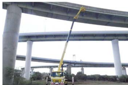
《橋梁下面の点検状況》
