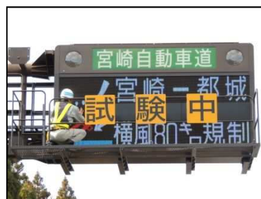
<情報板の点検状況>
