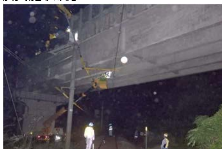
《橋梁下面の点検状況(鉄道交差)》
