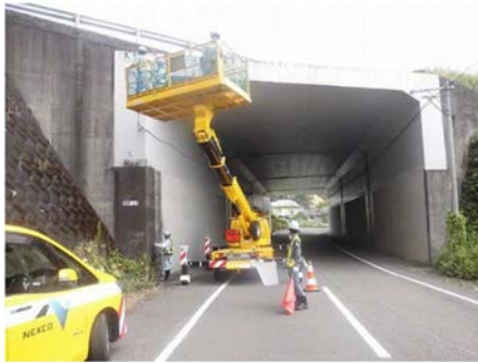
《ボックスカルバートの点検状況》
