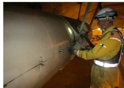
《トンネル換気設備の点検状況》
