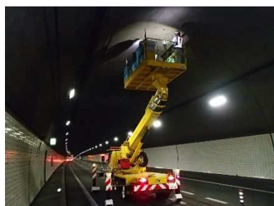
<トンネルの点検状況>
