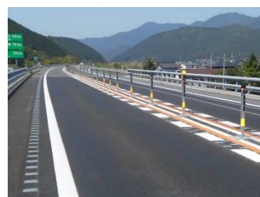
<ワイヤロープの設置(中小橋)>
