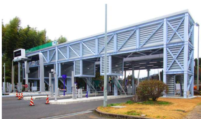
《料金所上屋通路》
