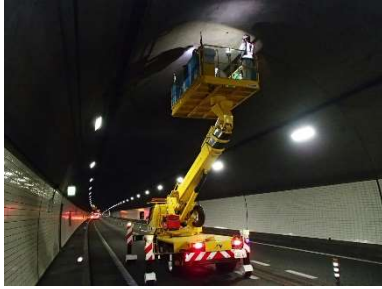
《トンネルの点検状況》
