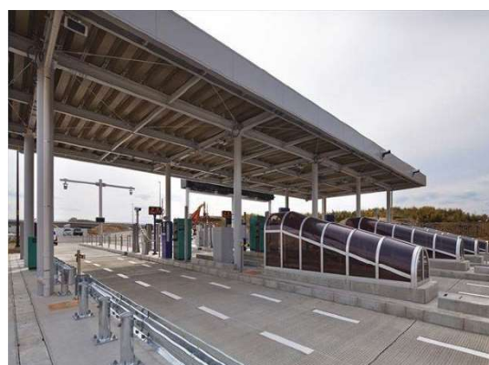
《料金所地下通路》
