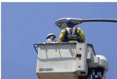
《道路照明の点検状況》
