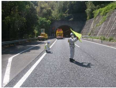
《路面の点検状況》
