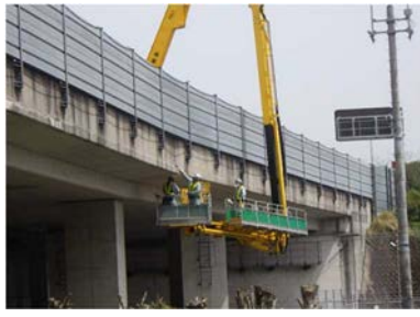
《橋梁の点検状況》
