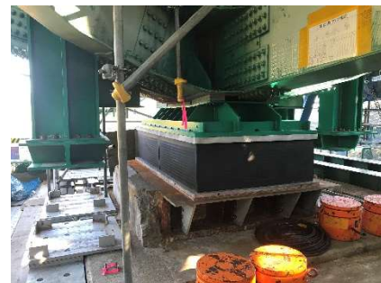
《補強後（支承取替）》
