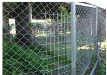
《立入防止柵の補修》
