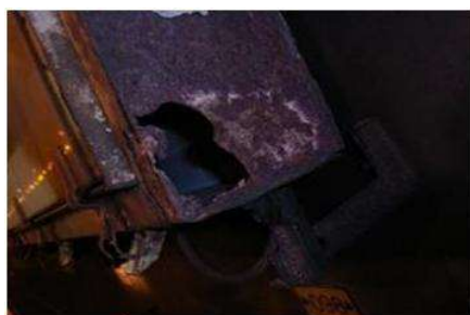
《トンネル照明の緊急補修（補修前）》
