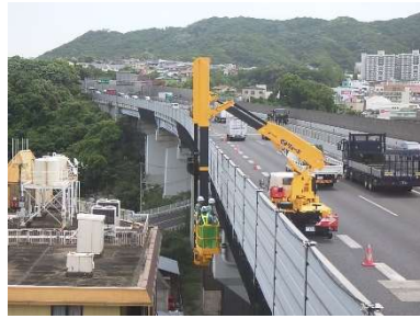
《遮音壁の点検状況》
