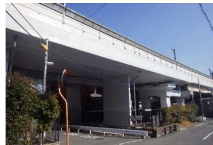
《橋梁上部工はく落対策（補修後）》
