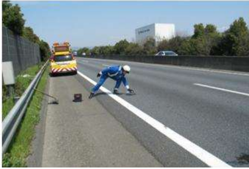
《交通パトロール時の簡易な舗装補修》
