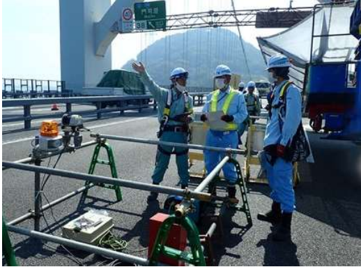
《安全パトロール実施状況》
