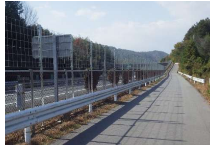
《動物侵入防止柵》
