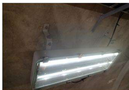
《トンネル照明の緊急補修（補修後）》
