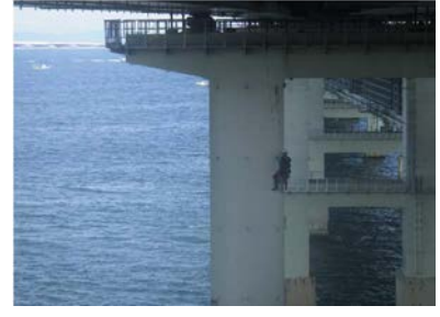
《橋梁の点検状況》
