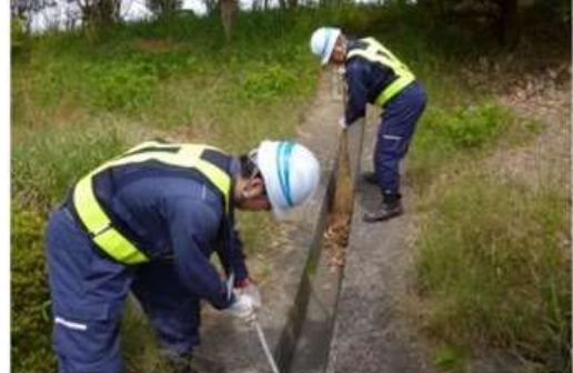
《不動産管理点検時の排水溝清掃》
