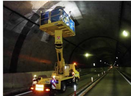
《トンネル覆工の点検状況》
