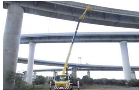
《橋梁下面の点検状況》
