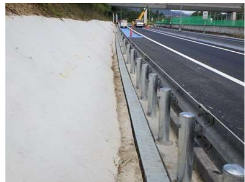
《埋設ケーブルのトラフ化》
