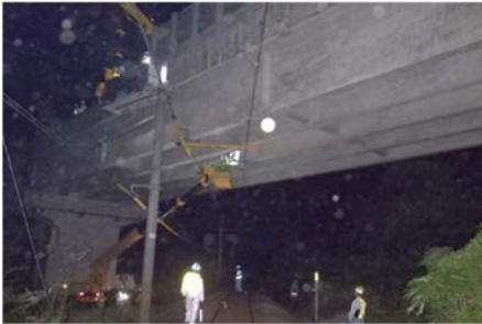
《橋梁下面の点検状況（鉄道交差）》
