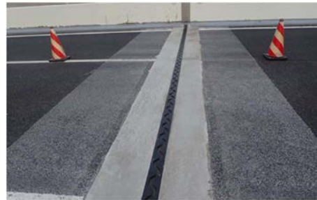
《伸縮装置の損傷（補修後）》
