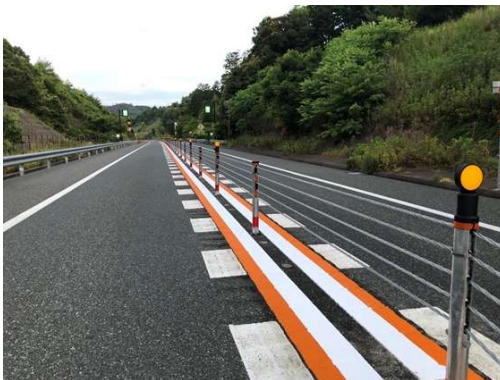
《ワイヤロープの設置》
