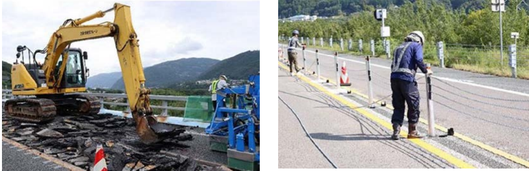
《終日通行止め内作業状況》
