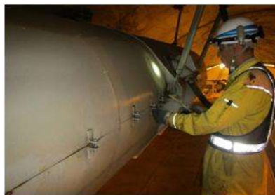
《トンネル換気設備の点検状況》
