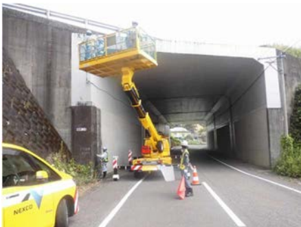
《ボックスカルバートの点検状況》
