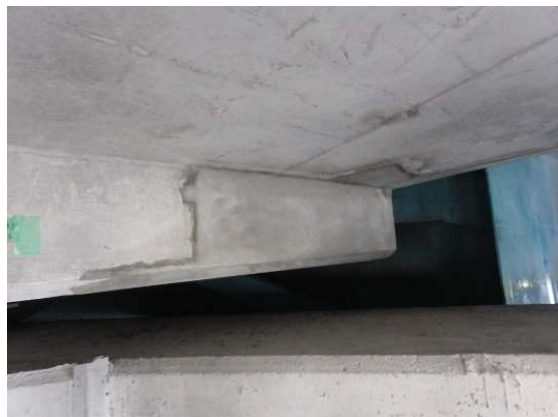
《橋梁桁端部補修（橋梁）》
