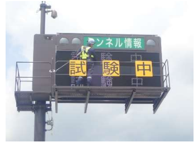
《情報板の点検状況》
