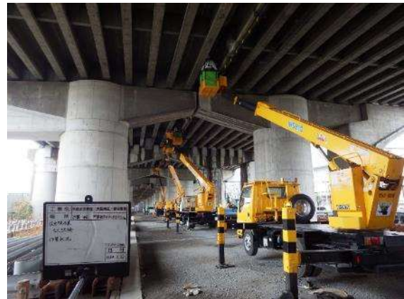
《コンクリート片剥落対策（橋梁）》
