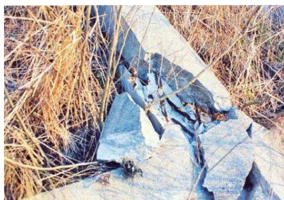
《地すべりの進行によるのり枠の変状》
