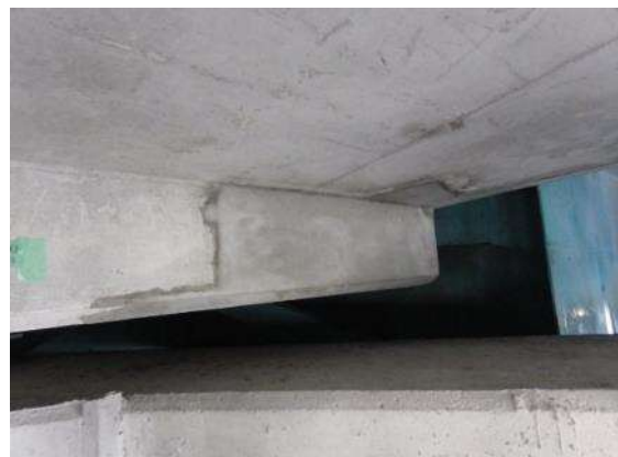
《桁端部補修（橋梁）》
