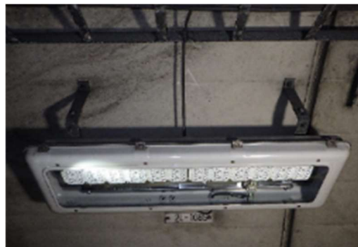
《トンネル照明の緊急補修（補修後）》
