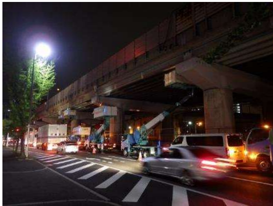
《コンクリート片剥落対策（橋梁）》
