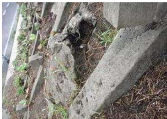
《グラウンドアンカーの機能低下によるのり面変状》
