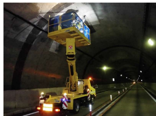
《トンネル覆工の点検状況》
