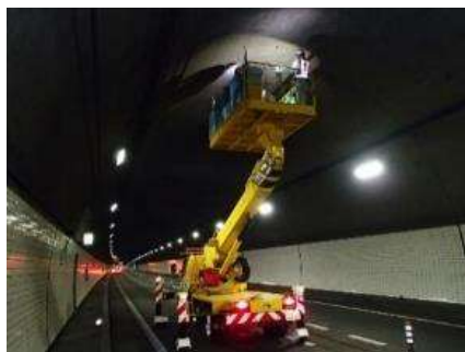
《トンネル覆工の点検状況》
