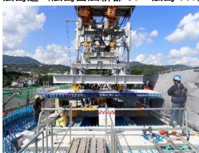
半断面施工による床版取替
