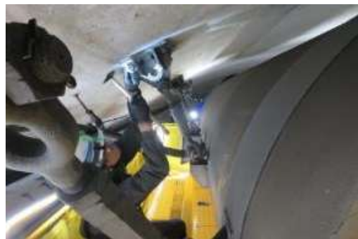
《トンネル換気設備の点検状況》
