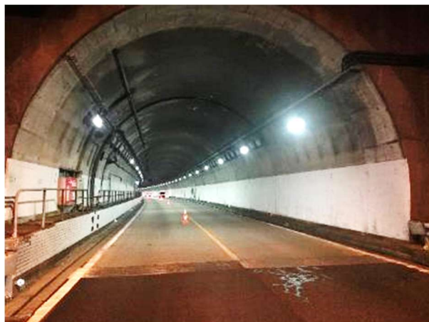
《トンネル照明の LED 化》
