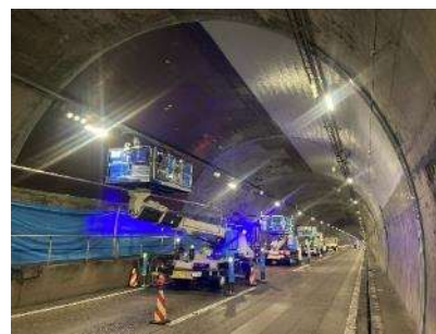
トンネル覆工補強
