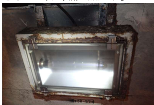
《トンネル照明の緊急補修（補修前）》
