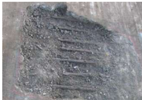
《床版上面のコンクリート土砂化》
