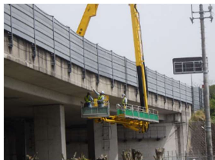
《橋梁下面の点検状況》
