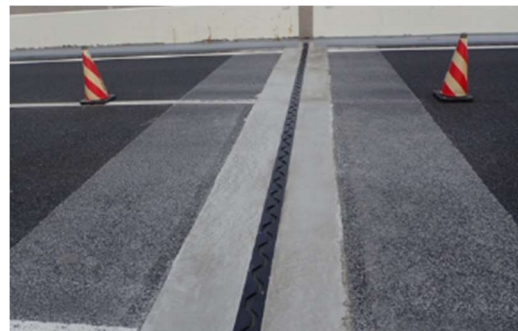
《伸縮装置の損傷（補修後）》
