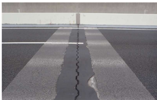
《伸縮装置の損傷（補修前）》
