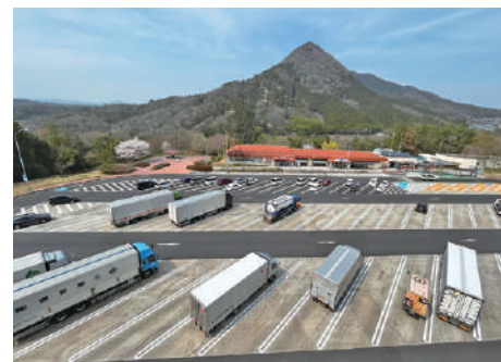
駐車マス拡充(中国道 安佐SA(上))
