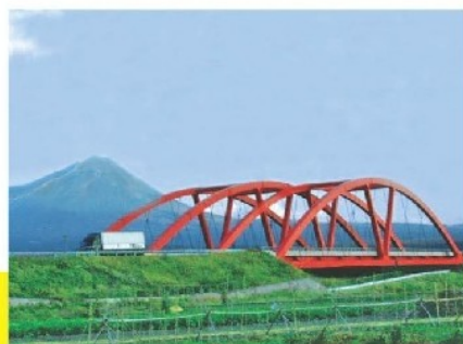
米子自動車道佐田川橋付近・大山を望む
