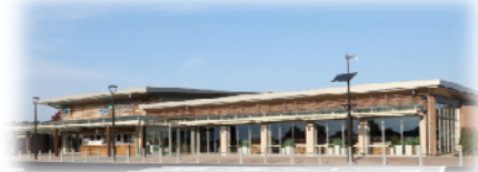
大分自動車道 山田SA(下り線)H24年11月21日
