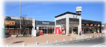
九州自動車道 宮原SA(上り線)H24年11月23日
