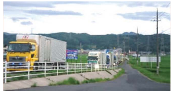
山陰道未整備区間での一般道混雑状況 (H30年7月8日19時ごろ)
