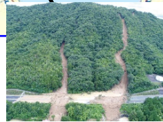
流木・土砂等の流入 /山陽道 (河内IC~高屋JCT)
