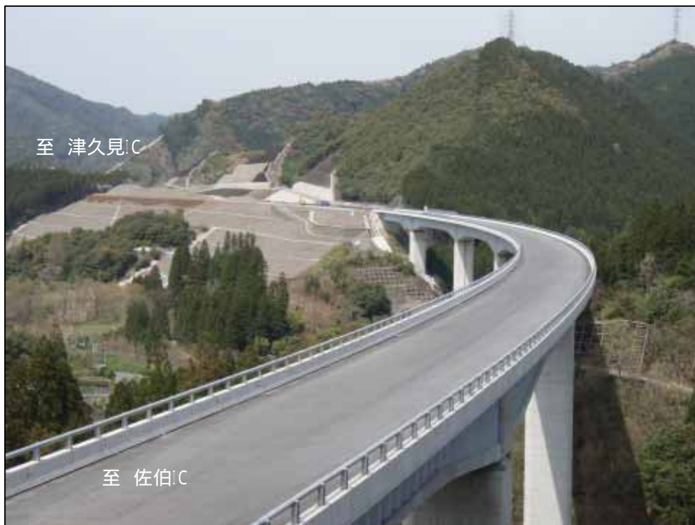
写真 【一ノ瀬高架橋付近 平成20年4月11日撮影】
