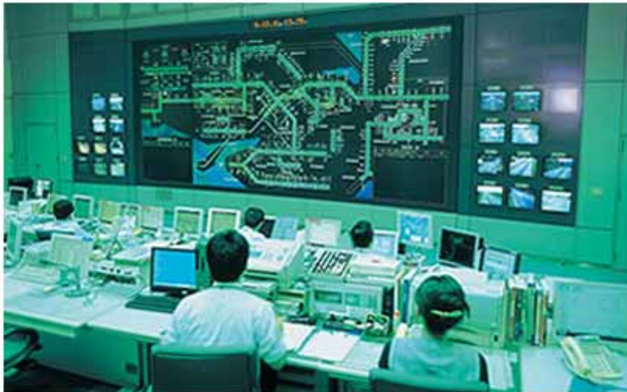
道路管制センター
