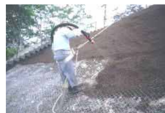
写真-3 堆肥を活用した植生工
