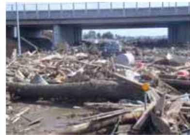
東日本大震災の津波被災状況
