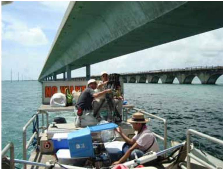
ハイビジョンカメラによる橋梁点検の様様
