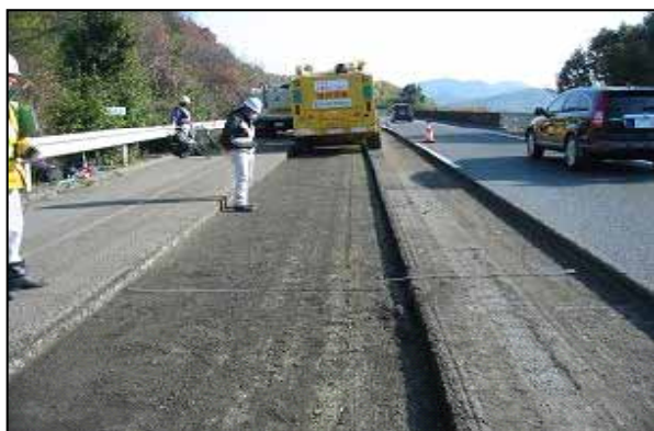
舗装の大規模補修
