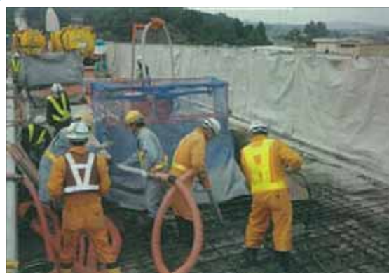
橋梁(床版)の大規模補修
