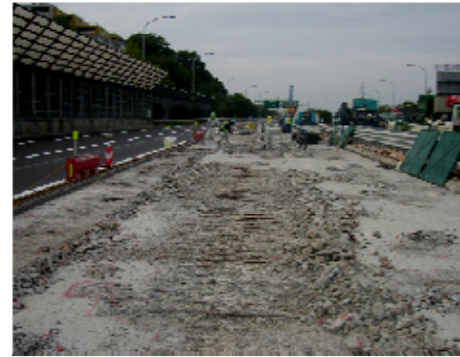
橋梁床版部の損傷状況
