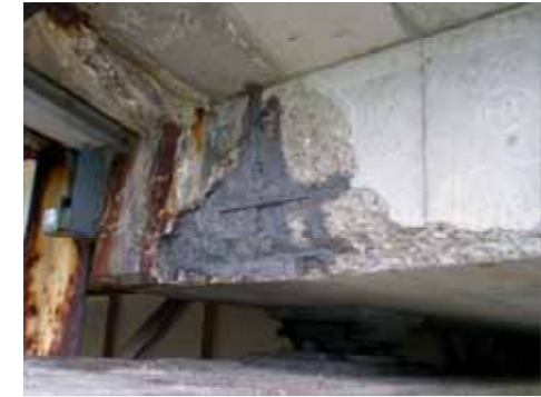
橋梁桁端部の損傷状況
