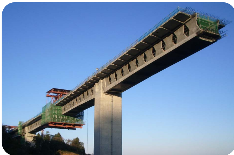
東九州道 寺迫ちょうちょう大橋
