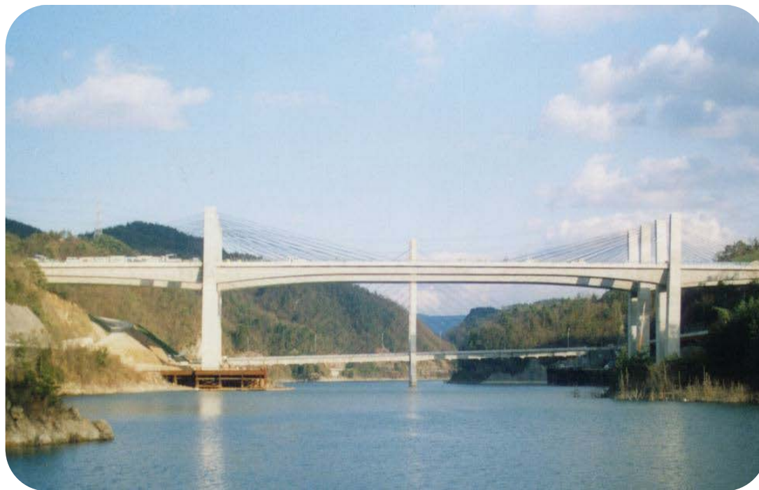
山陽道 つくはら 衝原橋
