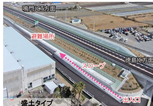
津波一時避難場所（整備状況）
