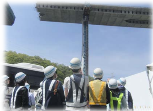
＜新名神高速道路 武庫川橋工事＞
