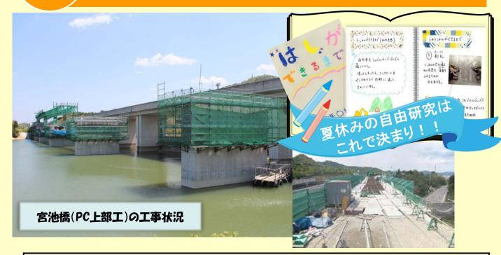
高松自動車道 4車線化工事は、平成30年度内の完成に向けて順調に進んでいます。 宮池橋(PC上部工)工事は、供用中の高速道路の横で安全に注意しながら、ため池を通過する ための橋(長さ364m)を施工しており、4月末現在、約200mまで橋ができあがっています。 当日は、特殊な工法を採用した工事の状況や現場で活躍する機械を見学いただきます。 夏休みの自由研究のサポートをさせていただきますので、楽しく宿題を完成させましょう!
