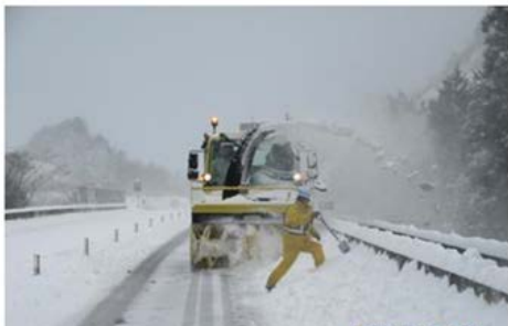
ロータリー除雪車による除雪作業
