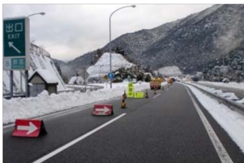
追越車線優先除雪による車線確保状況
