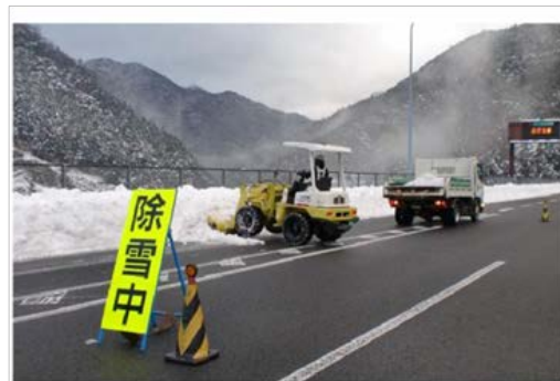
追越車線優先除雪による車線確保状況
