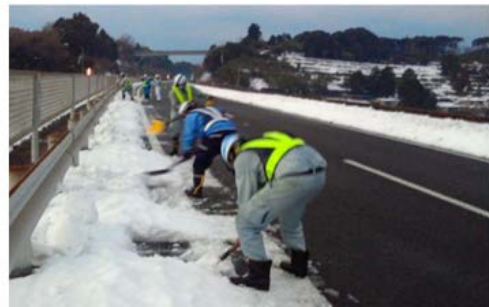
人力による除雪作業
