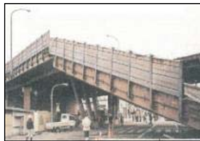
E1名神高速道路 瓦木西高架橋
