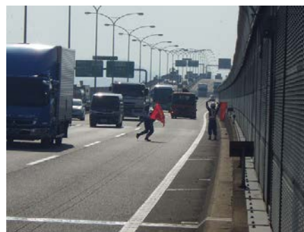
《落下物排除状況》
