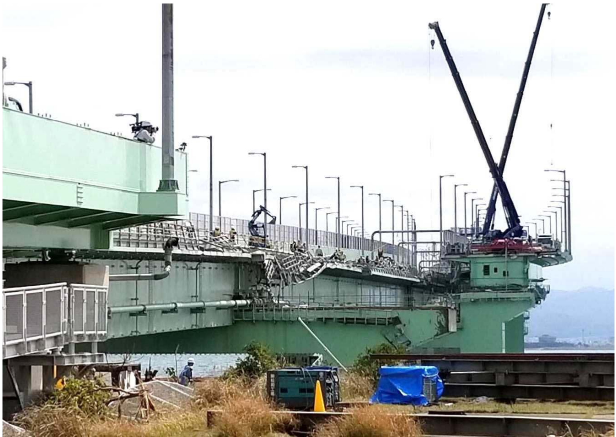
撤去状況(近景)
