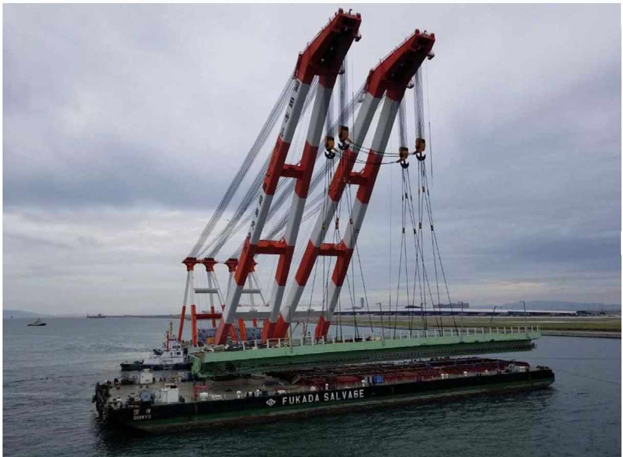
撤去桁台船積込状況
