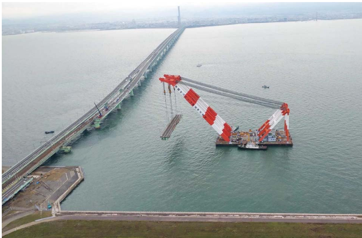
撤去桁吊り上げ状況
