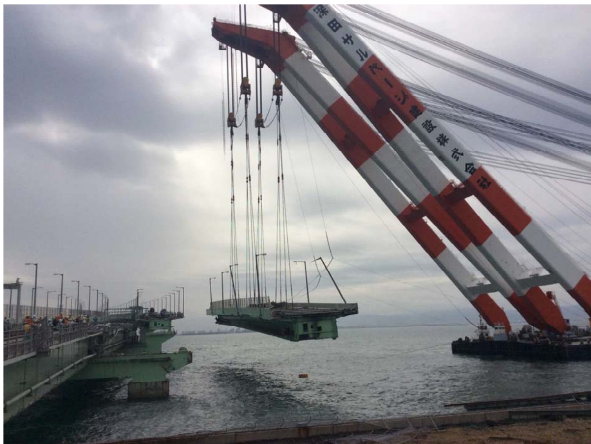
撤去桁吊り上げ状況
