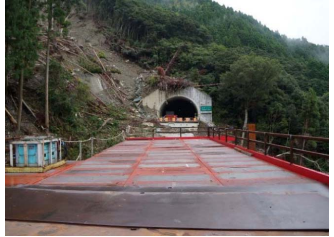
上り線部の仮橋約20m施工
