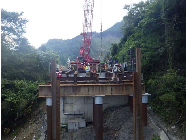
上り線部の仮橋の工事状況
