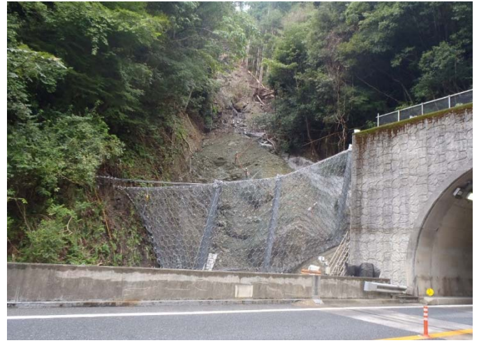
北沢部ワイヤーネット工 設置完了
