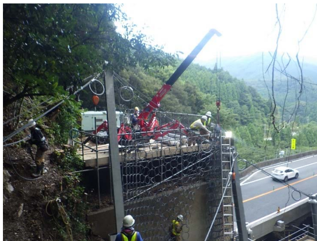
北沢部ワイヤーネット工 設置状況
