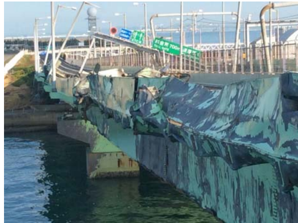
下り線 P1~P2桁 張出し部損傷状況
