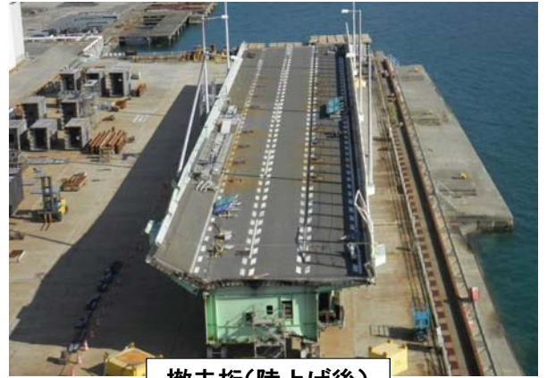
撤去桁(陸上げ後)
