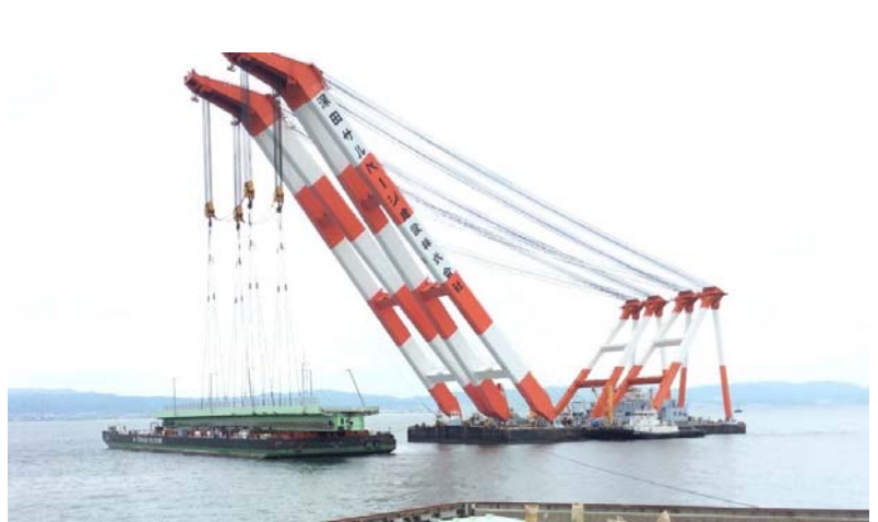
桁撤去作業(P1-P2)
