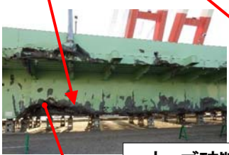
ウェブ破断、変形
