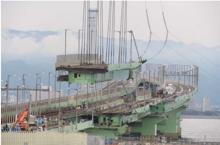
桁撤去作業(A1-P1)
