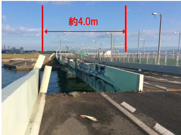
P2橋脚上 北側に約4.0m移動
