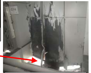
ウェブ破断、変形
