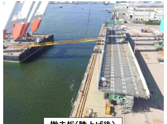
撤去桁(陸上げ後)
