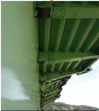
ブラケット破断変形
