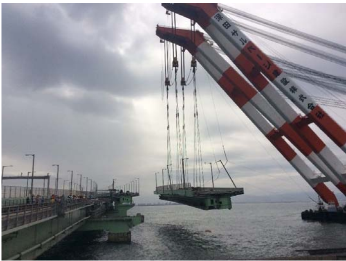
桁撤去作業(P1-P2)
