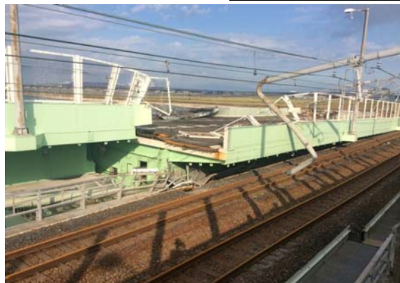
P2橋脚上 JR側に張出し部がせり出している状況
