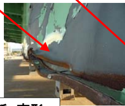
ウェブ破断、変形
