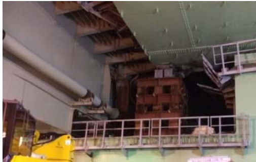
関西国際空港連絡橋 橋面下
