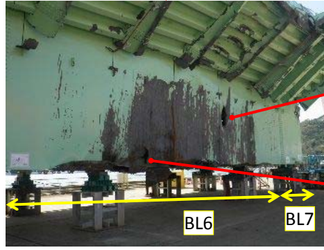
ウェブ破断、変形
