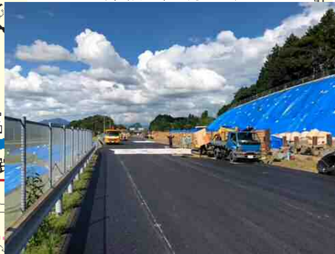
復旧作業状況 (令和元年9月8日)
