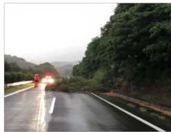
状況写真①
