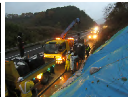
<応急復旧状況>
