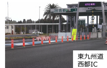
＜料金所プラザ部の開口部締切りの対策事例＞
