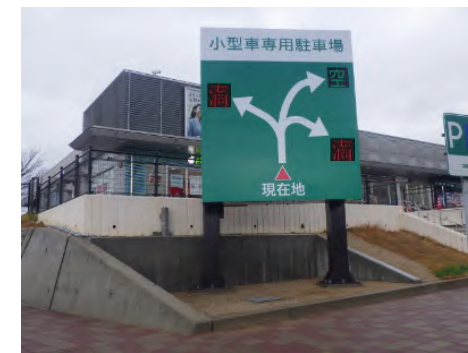
駐車場内の設置例 (九州道 古賀SA)
