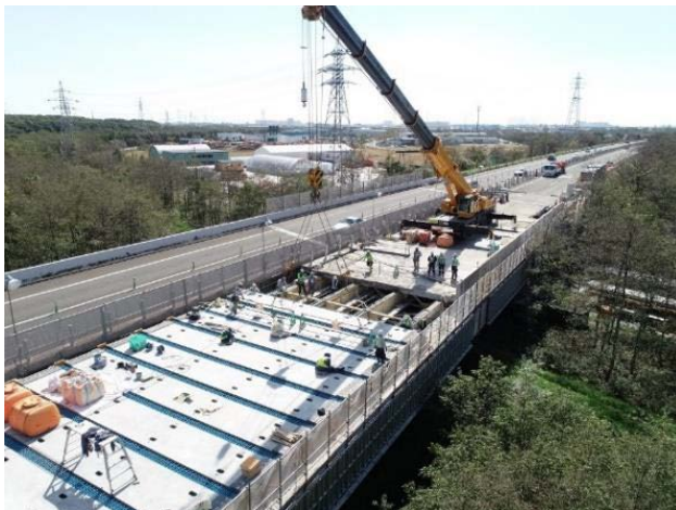
床版取替工事
