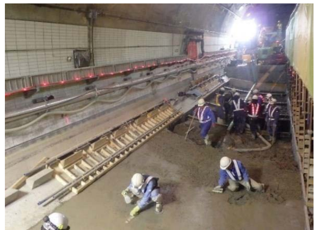
トンネルインバート設置工事
