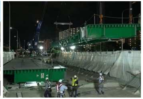
鋼床版・鋼桁
