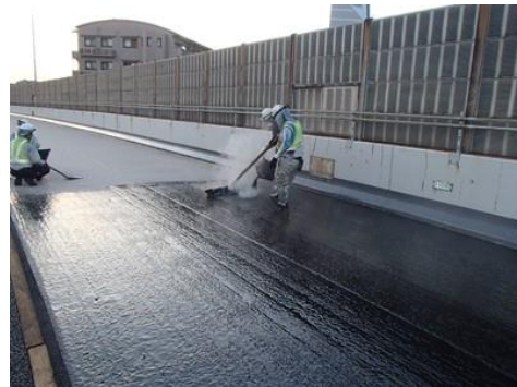
高性能床版防水工
