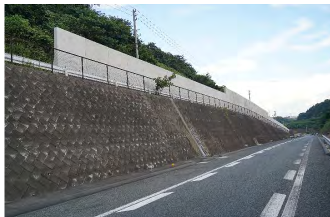
(仮設防護柵の設置)
