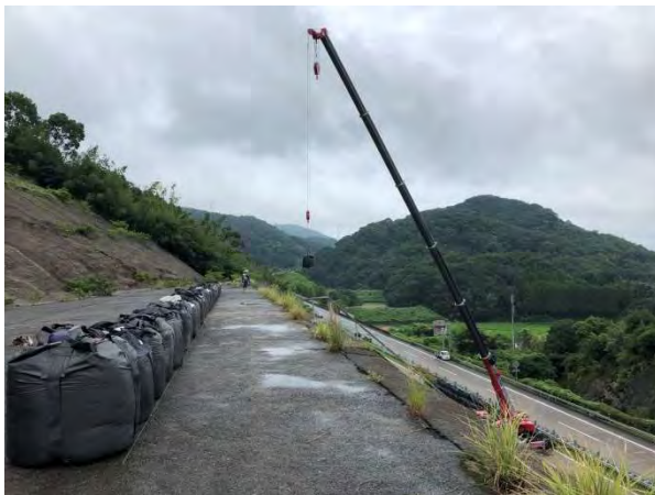
大型土のう設置
