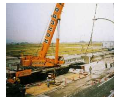
対策イメージ（桁の架替）
