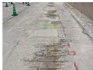
劣化が進行した床版 上面の状況
