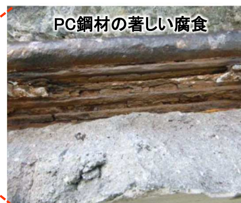
PC鋼材の変状状況
